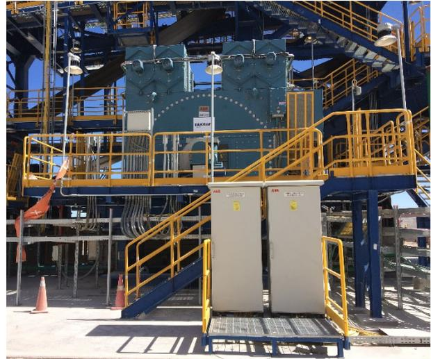
*Bild 4: 5 MW Antrieb nach der Montage*
