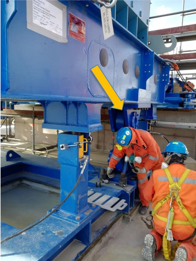
*Bild 6: Motorausrichtung bei der Montage*
