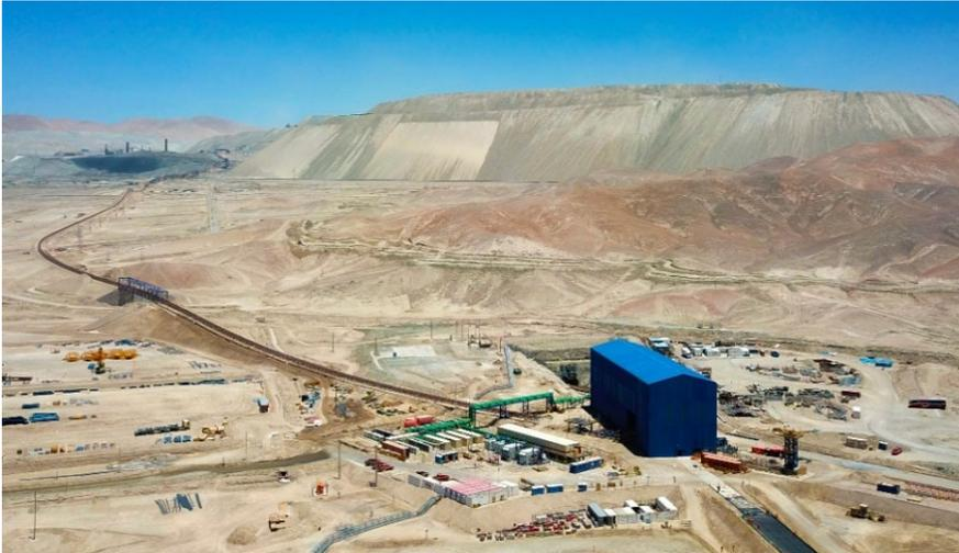
*Bild 8: Overland Conveyor OLC-01 mit Aufgabestelle im Antriebshaus des Schrägförderers C02 (blaues Gebäude)*
