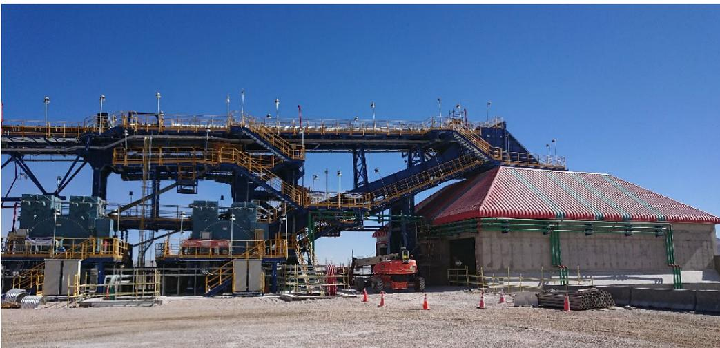
*Bild 12: Bunkergebäude mit Gutabwurf des Overland Conveyor OLC-01*
